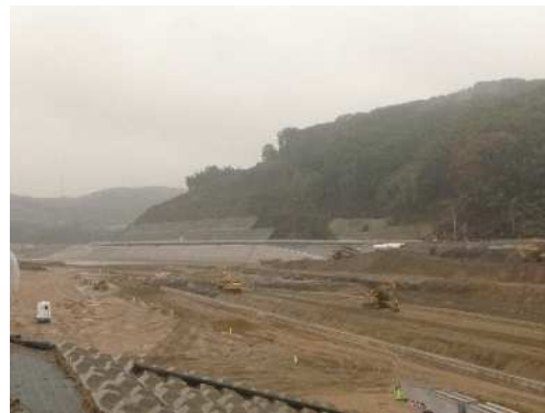
南山掘削状況を望む
