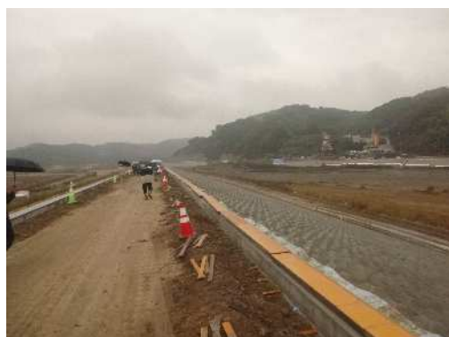
護岸施工状況
